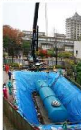
クレーンで吊り下げられ、設置される大型貯水槽
