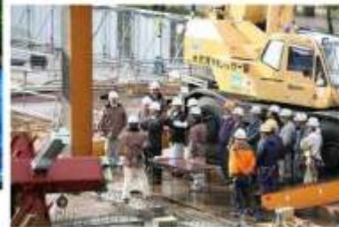
立柱式で工事の安全を祈願する関係者
